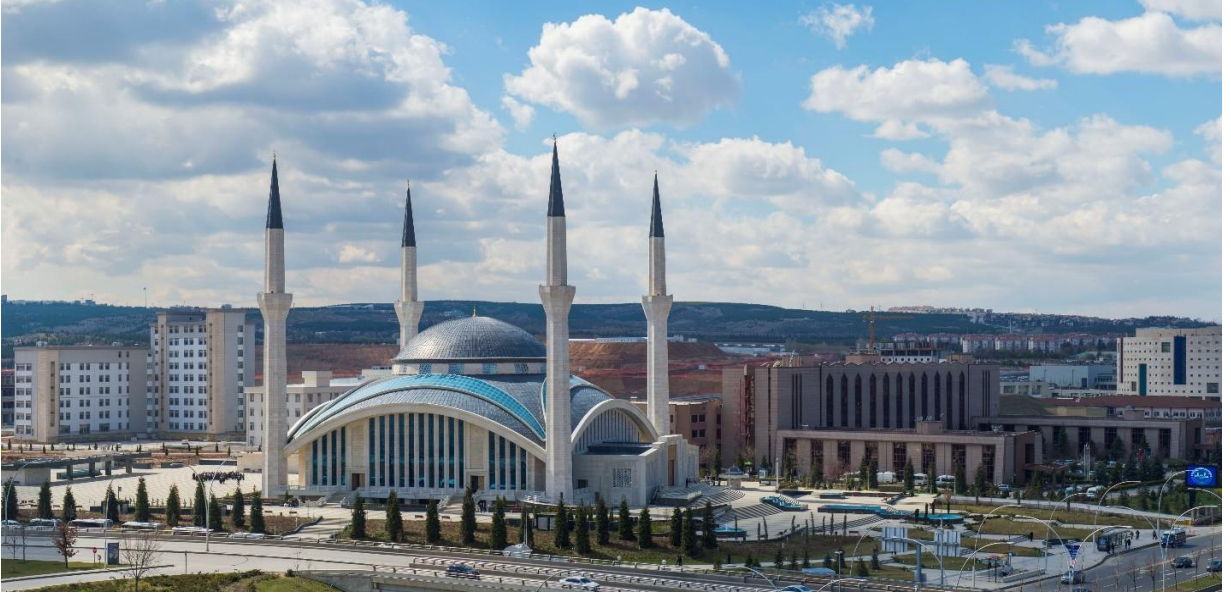
Resim-2 Başkanlık Hizmet Binası ve Ahmet Hamdi Akseki Camii (Karşıdan Görünüm)
